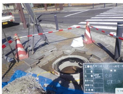
更新工事の様子
