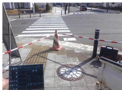
更新工事着工前
