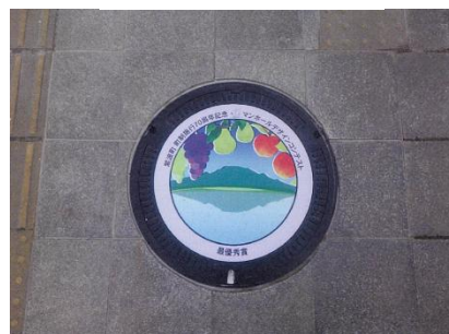
更新工事(設置)完了
